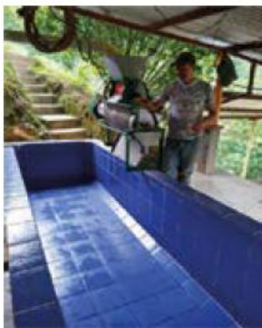
Tanque tina de concreto con esquinas internas en ángulo de 90° que propician la acumulación de microorganismos no deseables.
